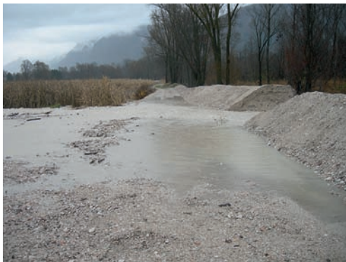
Figura 3: Evento alluvionale verificatosi nel 2010 che ha comportato la fuoriuscita di materiale ghiaioso dal rio Vena
