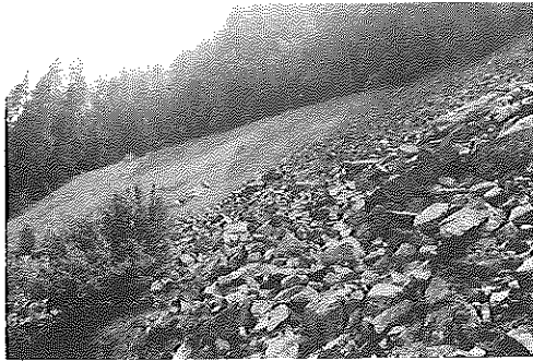
Foto n. 4 - Ex discarica di Albiano.
