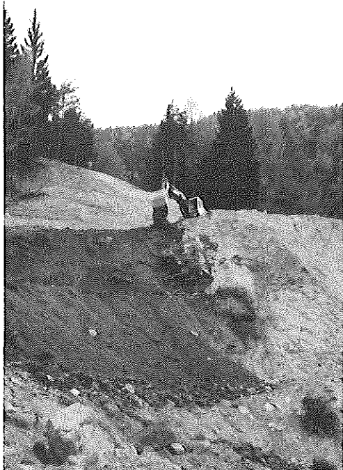
Foto n. 7 - Interventi sulla frana a Gaggio di Segonzano.
