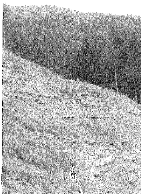
Foto n. 9 - Frana di Gaggio- Segonzano.
