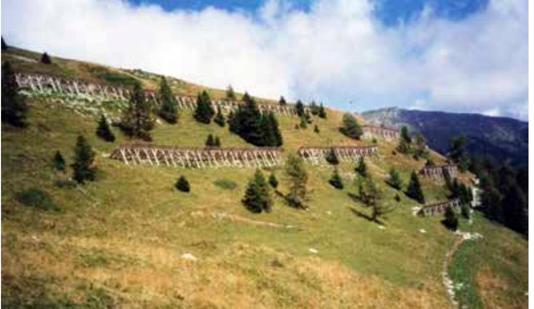
L'elicottero si rivelò strumento particolarmente versatile nei lavori in montagna, come nel caso della realizzazione nel 1999 di barriere paravalanghe nella zone del passo Brocon, valico che, nel Trentino orientale, collega la Valle del Vanoi con il Tesino.
